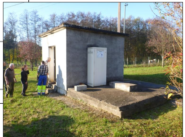
Vue extérieure de la station de pompage
